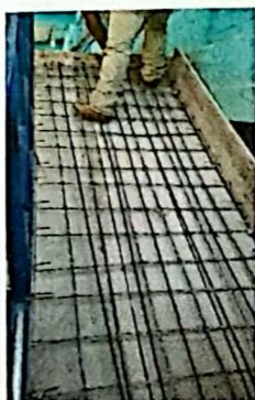
Foto 3: Haciendo instalacion de energia electrica y parrilla para gradas
