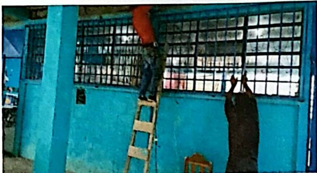
Foto1: Haciendo instalacion de vidrios y balcones
