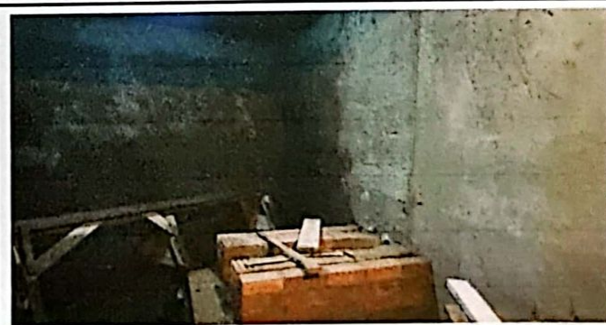
Foto 6: realizando repello en paredes
